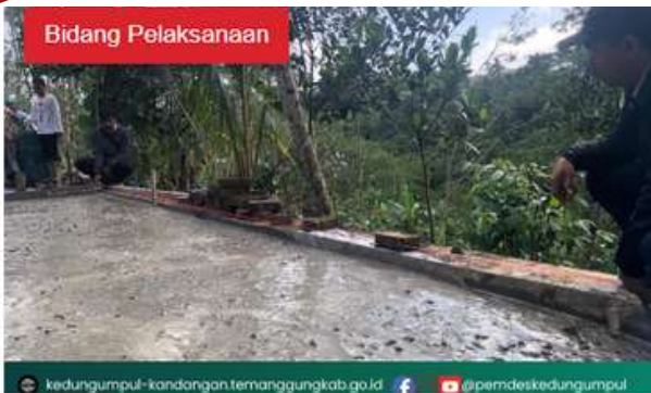
Trial Pembangunan Jalan Usaha Tani (JUT) di Dusun ...
